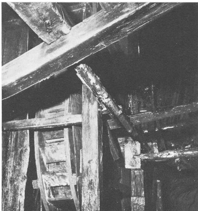
Silberberg: Schöpfrad im Andreasstollen, 3.60 m Durchmesser. Das Wasser wurde ihm im Förderschacht durch Holzteuchein zugeführt. Das Schöpfrad diente auch als Förderkraft für das Erz.
