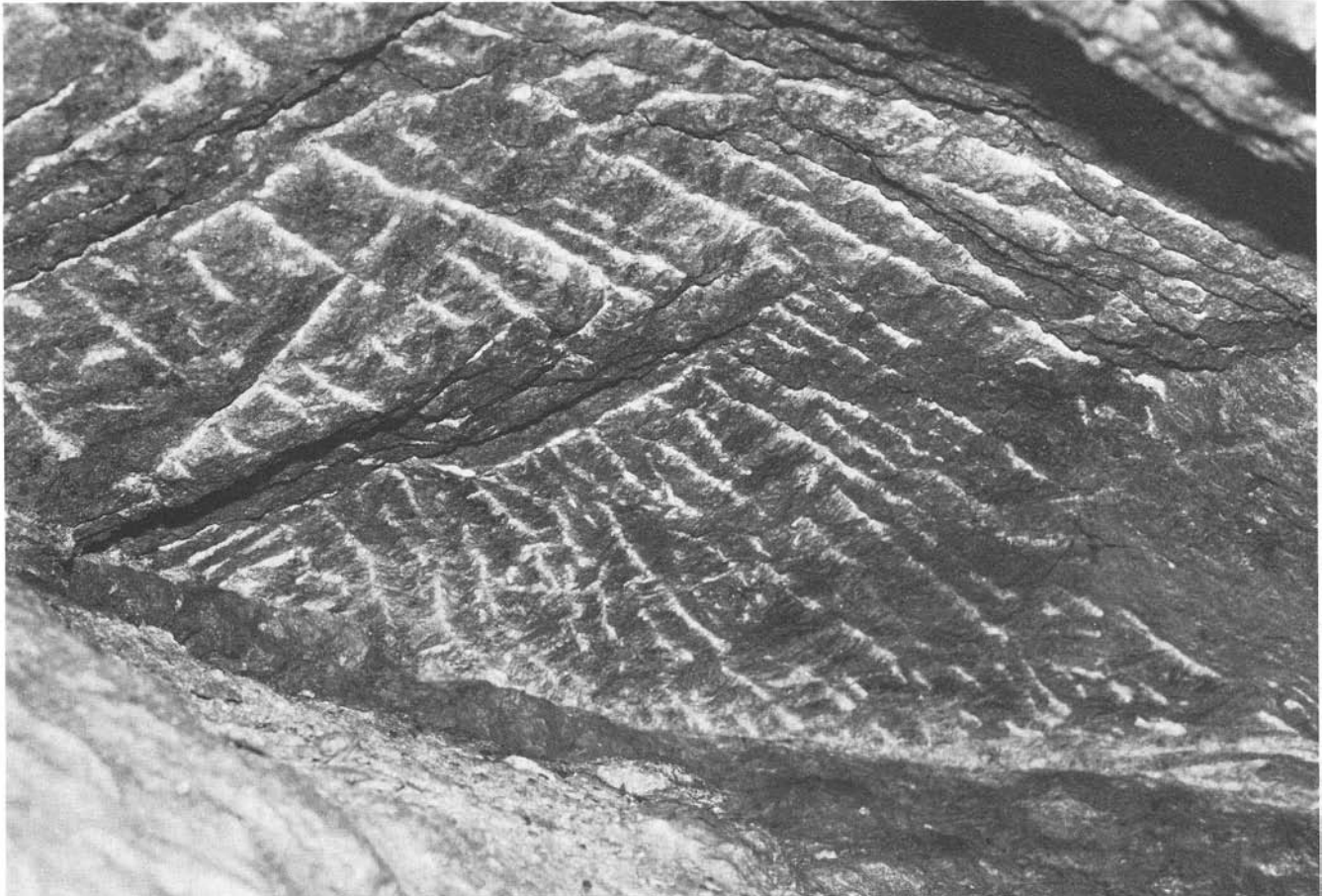
Schrümpfsuren der beim Vortrieb verwendeten Bergeisen in einem Stollen bei Sils-Baselgia.
