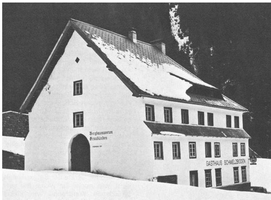
Das Bergbaumuseum in Graubünden im Schmelzboden Davos befindet sich im einstigen Verwaltungsgebäude des Silberbergwerks.
