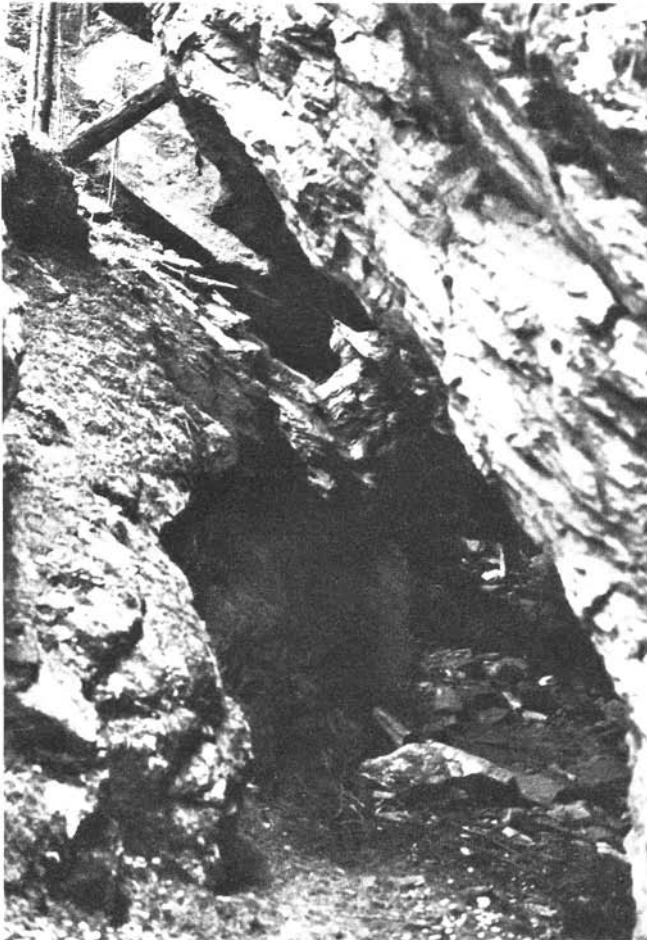
12 Meter tiefer Abbauschlitz, der mit Hilfe eines stehen gelassenen Erzpfeilers abgestützt wurde.
