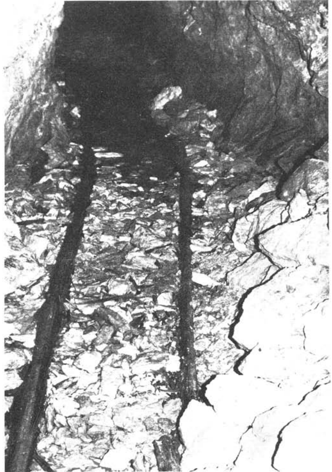
Holzschienenreste im Bergwerk Ursera.
