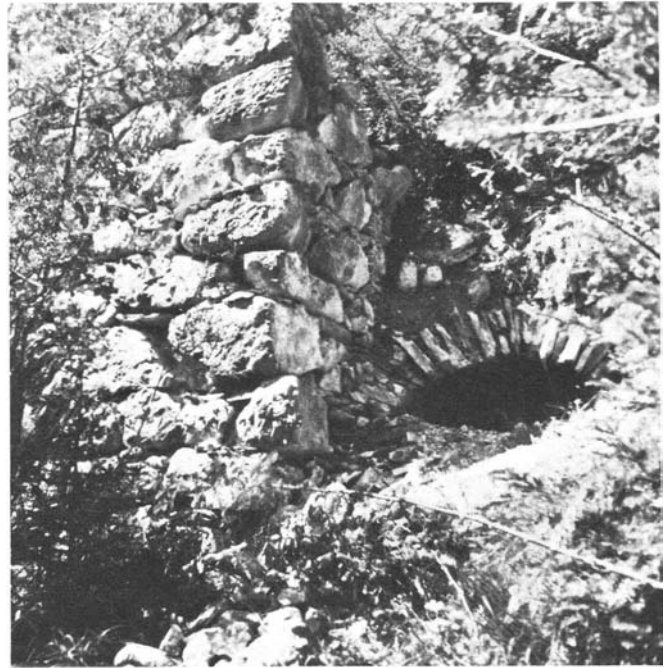
Das Gewölbe zur rechten Blasöffnung ist vom nachgerutschten Hang fast ganz verschüttet und überwuchert.
