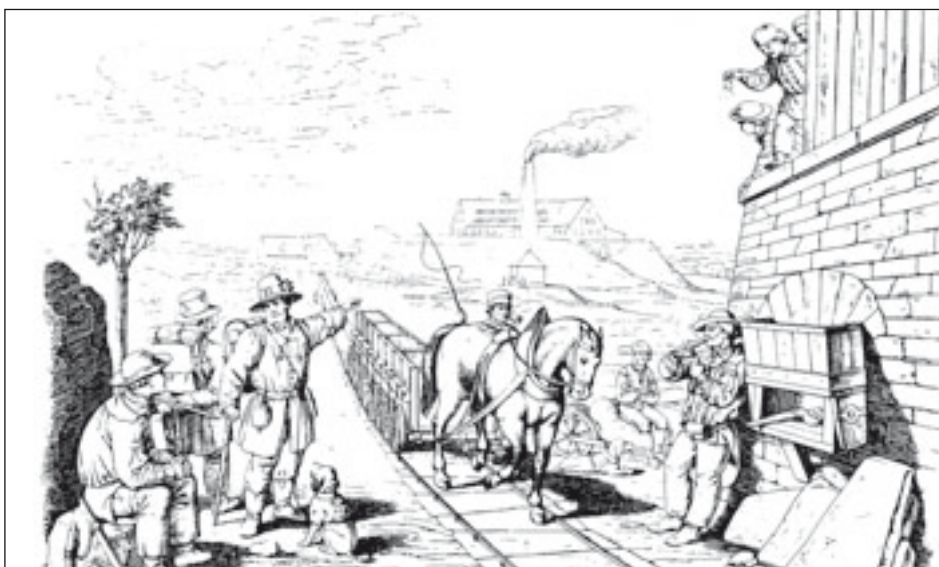
Abb. 11: Eine 1857 veröffentlichte Zeichnung von Professor Eduard Heuchler zeigt die Pferdeeisenbahn der Himmelfahrt Fundgrube an der Erzrolle des Abrahamschachtes.
