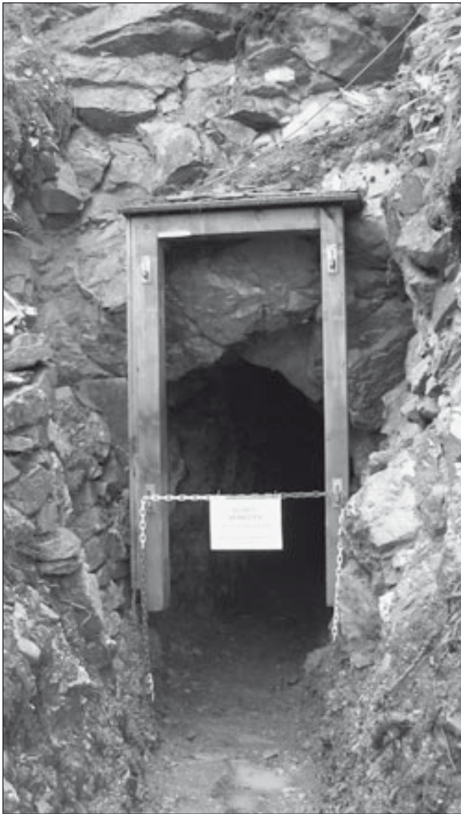
Abb. 1: Zustand der zerrütteten Zone des Mundlochs.
