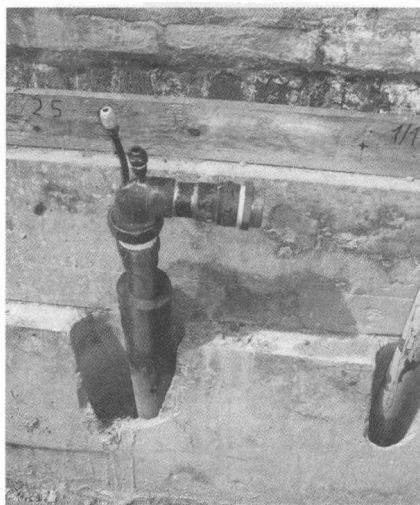
Bild 12. Gefrierrohrkopf
