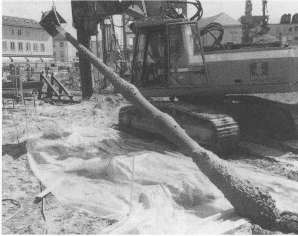
Bild 9. Gefrorene Bodenprobe an Gefrierlanze
