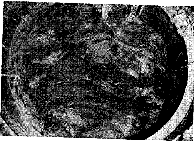
Abb. 3. Spannungsbruchstrukturen an der Ortsbrust.
