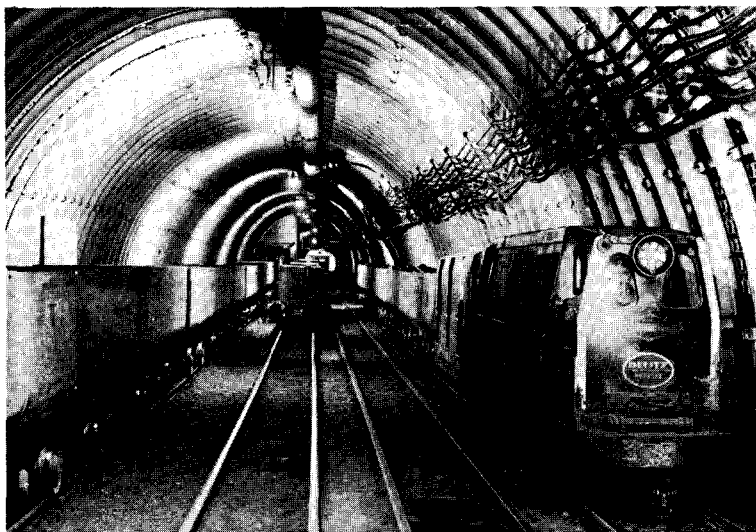
Abb. 5. Lokomotiv-Förderung im Füllort der 1000m-Sohle am Zieglmeierschacht.
