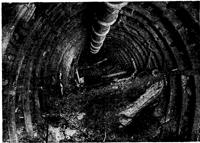
Abb. 1. Bankig aufgeschobene Streckensohle in 900 m Teufe (Gleitbogenausbau).
