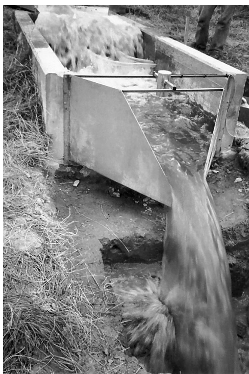
Fig. 56: 2-ft-H-flume near Mettmann/Germany (courtesy Umwelt-Geräte-Technik GmbH Müncheberg).
